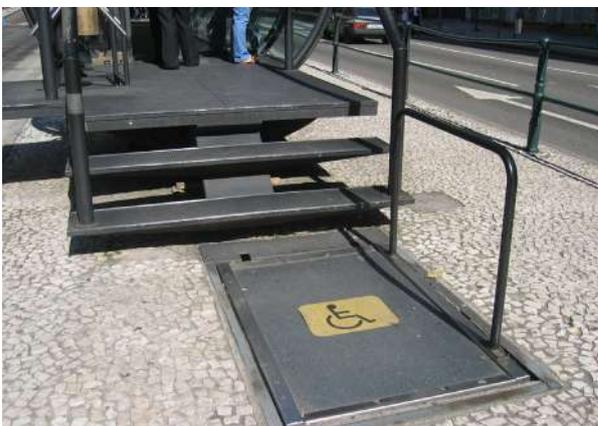
Figura 42: Solución técnica para el acceso sin barreras a una estación BRT en Curitiba, Brasil. ©Karl Otta 2005
