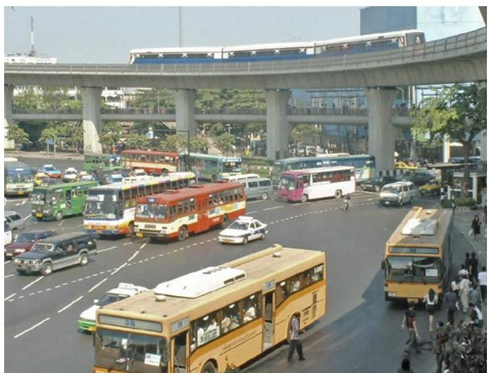
**Hình 21: Công trình Victory, Băng Kốc. Các đoàn tàu BTS chạy trên các đường đòn, trên một cầu cạn rộng 9m được đỡ bằng các dầm cầu vượt hộp đơn, mỗi dầm cầu cao cách mặt đất 12m**
