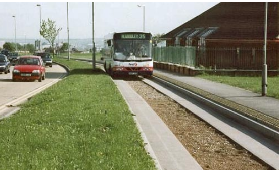
Fig. 13 Ipswich, England. La cinta central no pavimentada reduce costos considerablemente, y, además, reduce el ruido.
