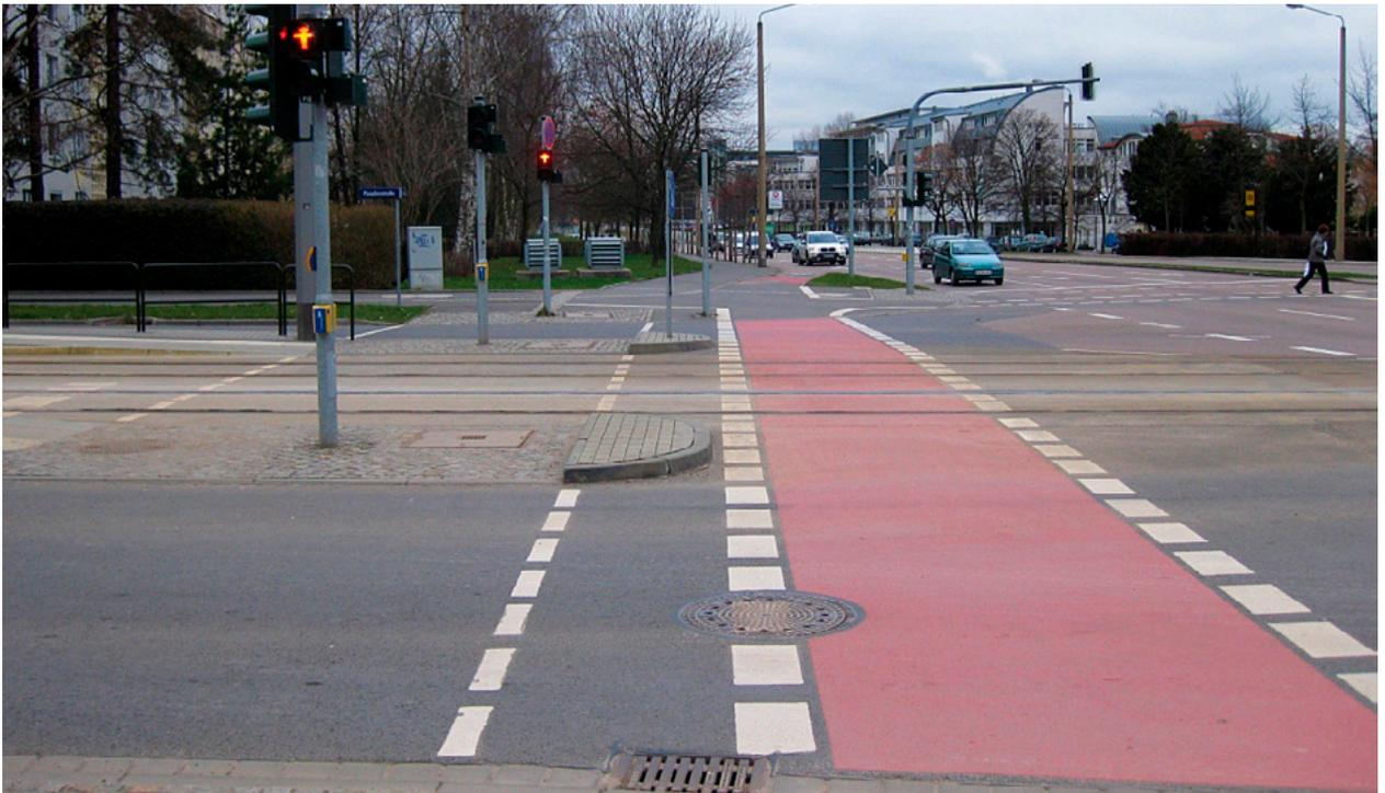
**Figura 14:** Marcações vermelhas na interseção com ciclovias aumentam a atenção dos motoristas em relação aos transportes ativos.
