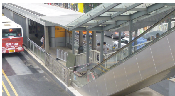
Figura 13: Escaleras mecánicas no funcionan en una estación de BRT. Foto de Heather Allen.
