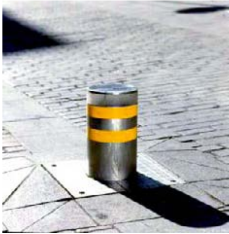
图129 一个电子控制的卡片激活式护柱可以作为灵活而稳定的路障
