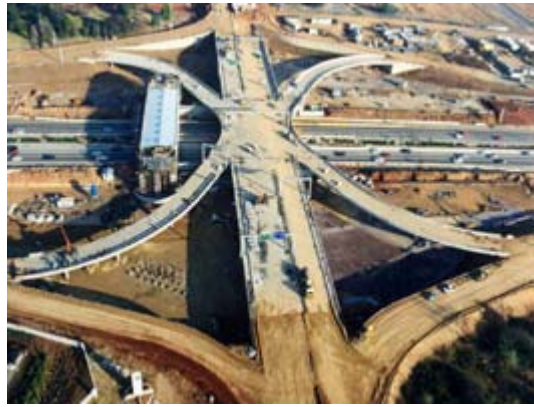
图 90 南非 Midrand 的公路建设大量采用机械设备而不是人力作业 (摄影: Lloyd Wright)
