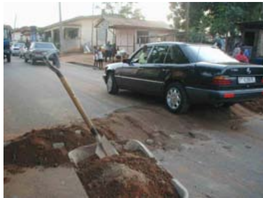
图 39 在阿卡拉居住区，居民修建了速度缓坡降低事故率
