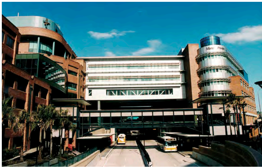
图41: 布里斯班(澳大利亚) BRT车辆独占 所有道路空间。 图片来自于Queensland Transport
