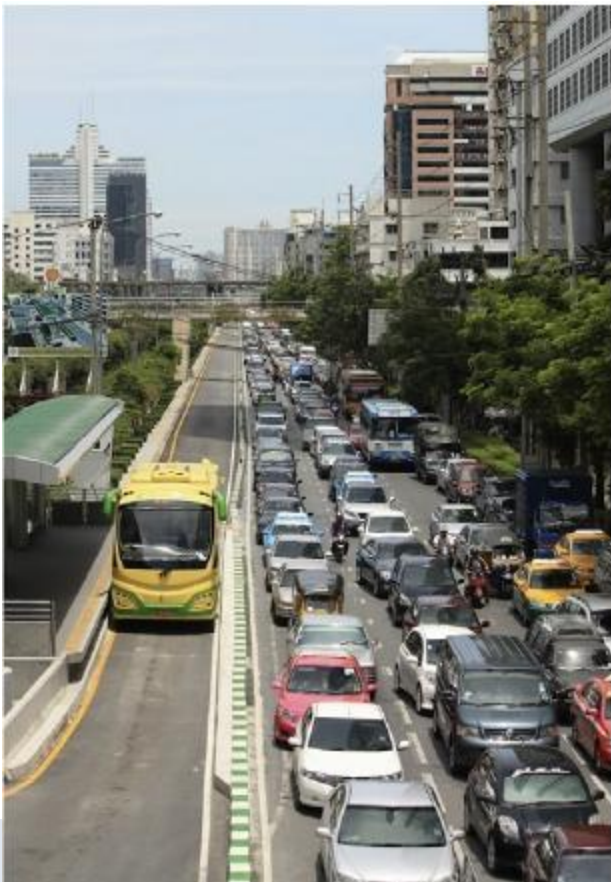
Hình 21: BRT có làn đường riêng cho xe buýt ở Bangkok, Thái Lan Nguồn: Santhosh Kodukula, 2010
