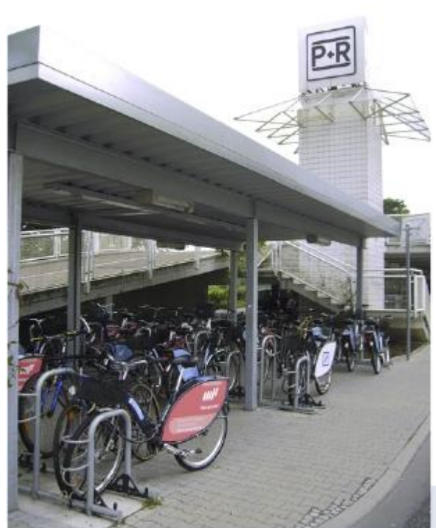
Hình 43: Xe đạp công ty đặt tại trạm ở Eschborn Sud, Đức. Nguồn: Jonathan Gomez, 2011
