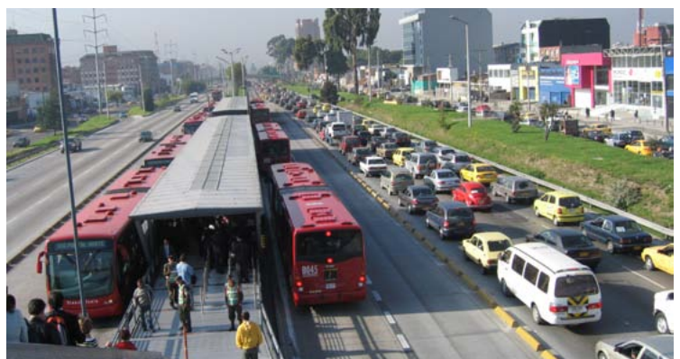
Gambar 50 Stasiun BRT ditempatkan di jalur jalan raya. Jalur khusus menghasilkan waktu perjalanan yang lebih singkat.
