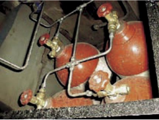
图 23： 改造公交车中没有压力释放环的 CNG 管道 (科学与环境中心, Erlandsson 和 Weaver, 2002)
